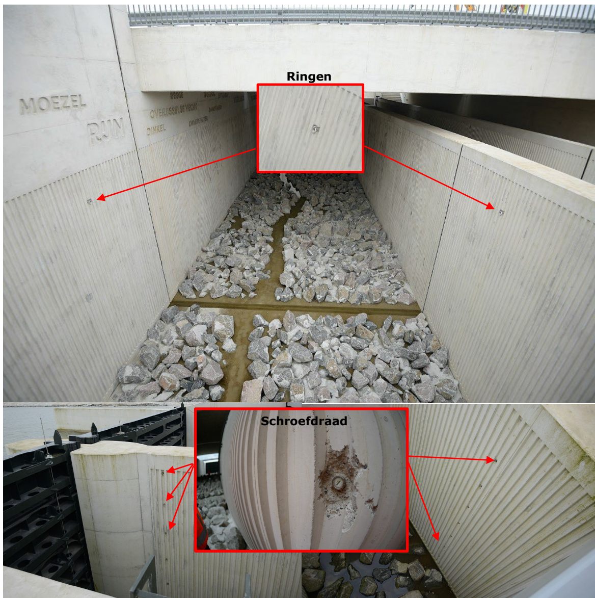
Foto 4. Bevestigingsmateriaal zoals in de Coupure is aangebracht t.b.v. bevestiging onderzoeksmateriaal.
