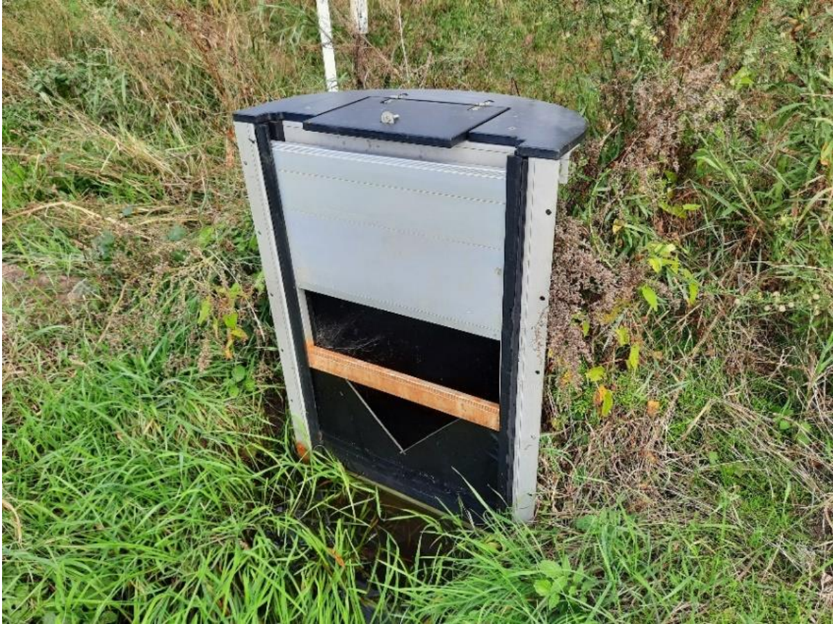
Figuur 3 Het plaatsen van stuwtees voor duikers kan water in kleine watergangen worden vastgehouden. Foto: Vince Kaandorp.
