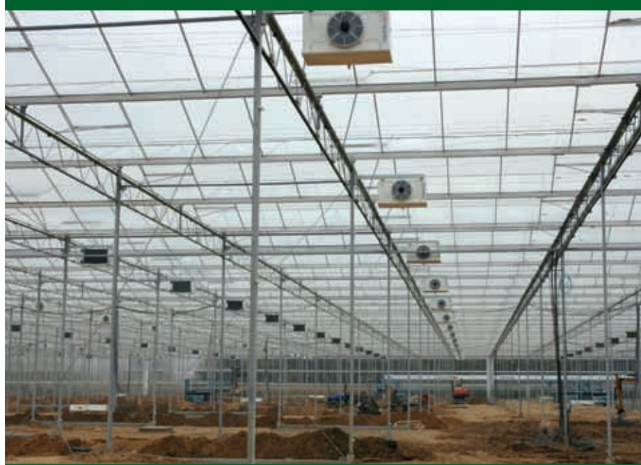
Omdat de plant juist bovenaan gekoeld moet worden, hangt de koeling in de Greenportkas bovenin. Voor een goede verdeling hangt op elke honderd vierkante meter een koelblokje.
