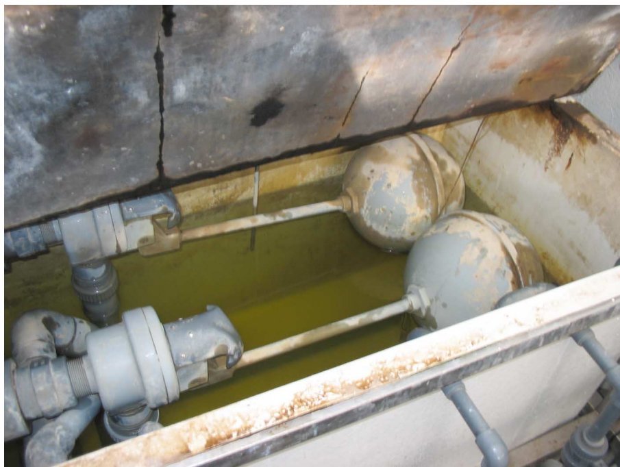
Figuur 4 Recirculatiepomp bij een rozenbedrijf in de regio Aalsmeer
