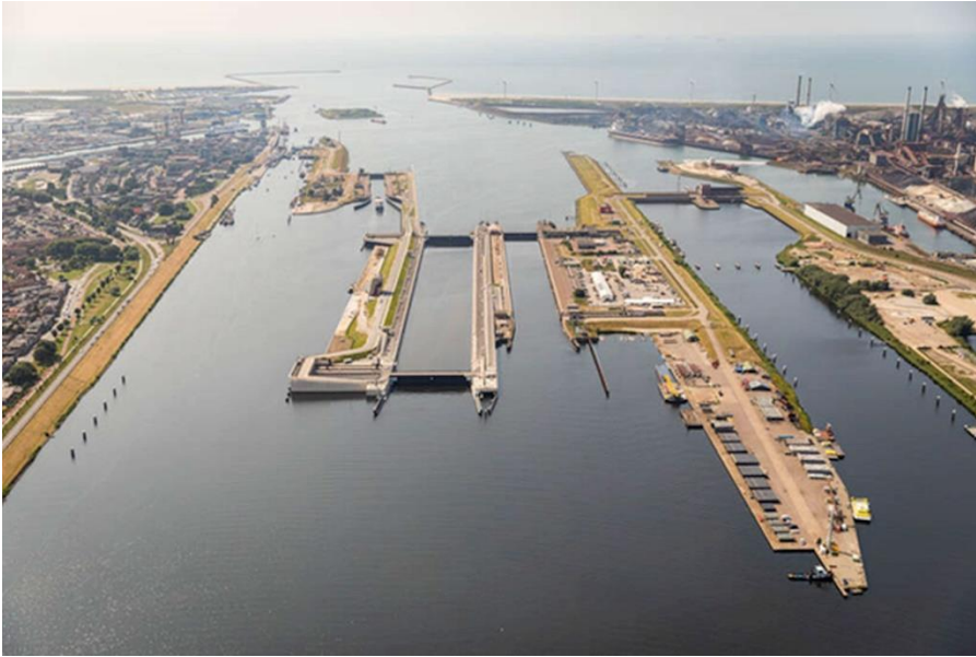
Afbeelding 2. Sluizencomplex in IJmuiden met in het midden Zeesluis IJmuiden. Foto Topview Luchtfotografie
