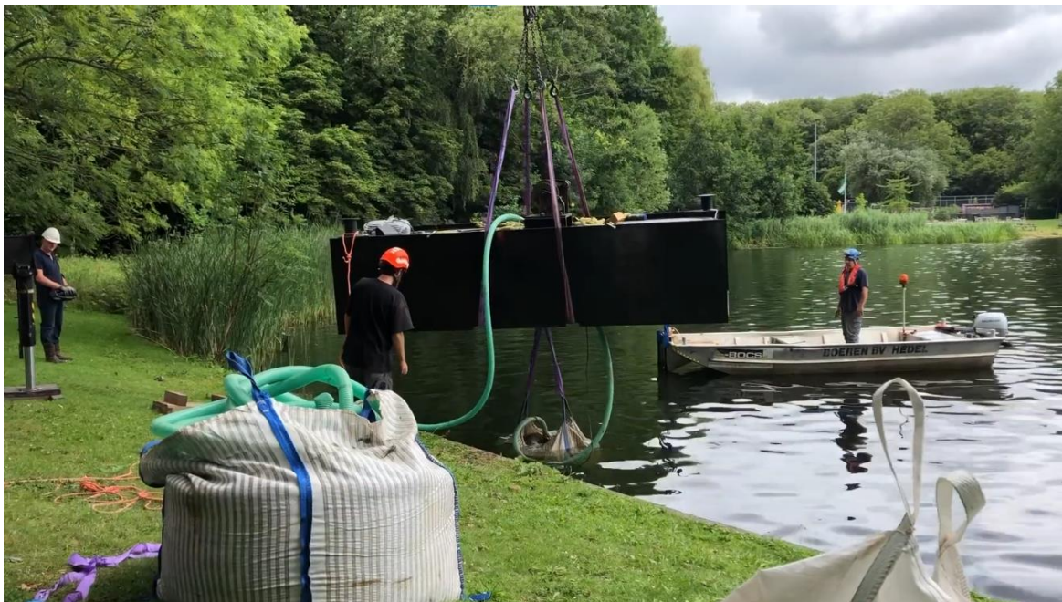
Afbeelding 2. Drijver met big bag wordt in de plas geplaatst. (foto: Delfland)
