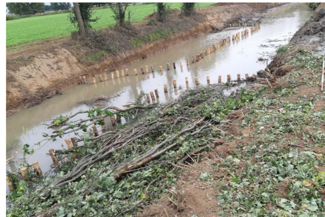
Langshout: lange takken in los verband achter een rij palen (foto Bram Spierings).
