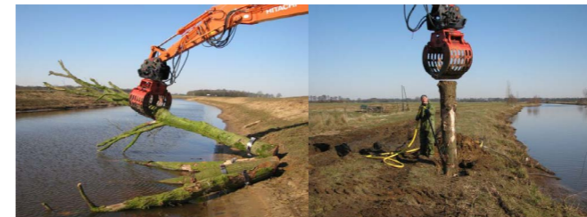
Plaatsen van een boom met mobiele kraan (links) en plaatsen van een ankerstam met spuitlens en kraan (rechts) [18].
