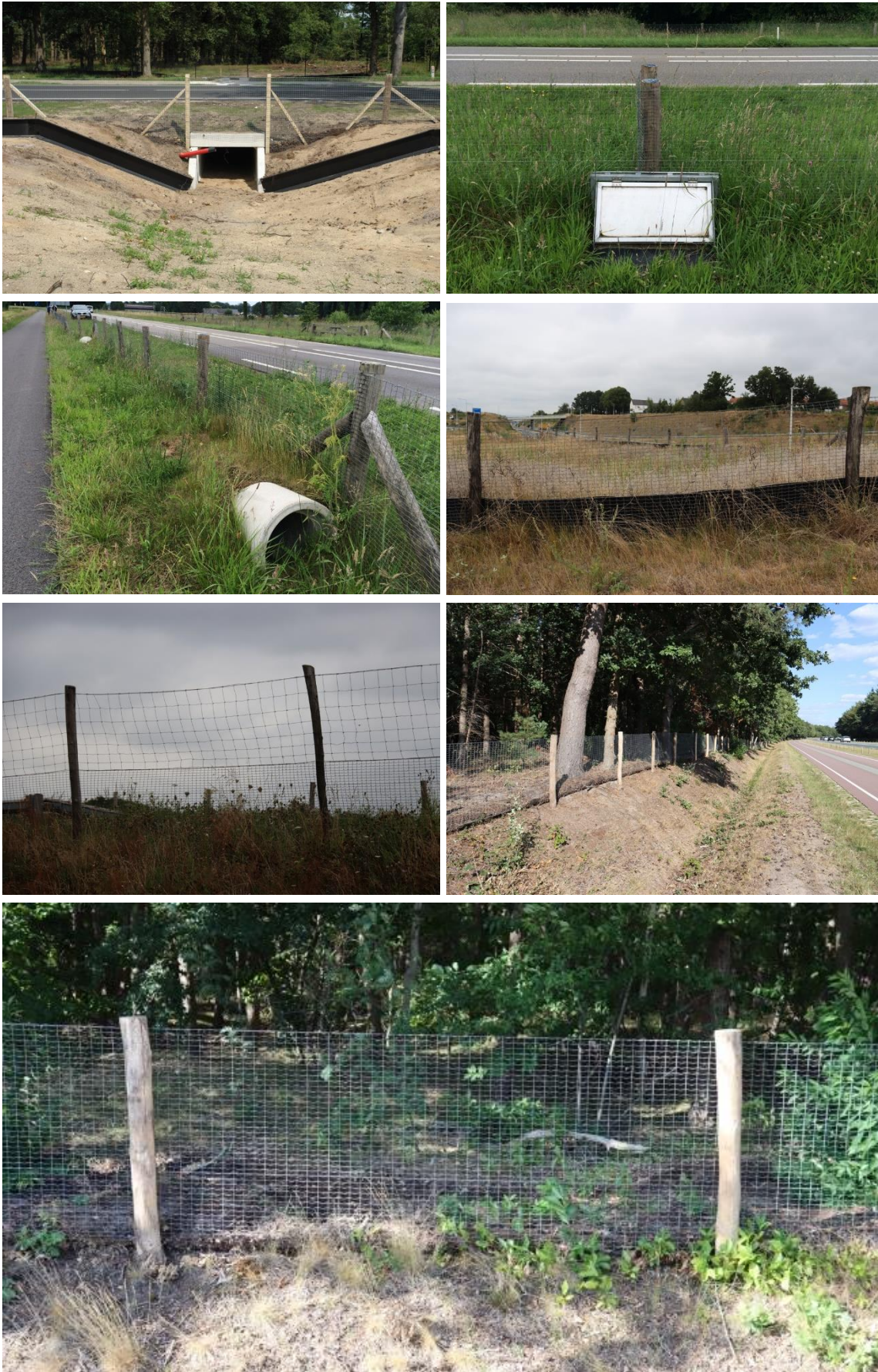
Figuur 6 V.l.n.r. en van boven naar beneden enkele illustraties van mitigerende maatregelen langs wegen voor de das. 1) illustratie van een kleine faunatunnels met dassenraster, 2) dassenraster met een dassenklep, 3) dassenraster met fauna duikerbuizen onder de weg door, 4) dassenraster gecombineerd met amfibiescherm, 5) dassenraster gecombineerd met grofwild raster, 6 en 7) voorbeelden van alleen een dassenraster van 120 cm hoog.
