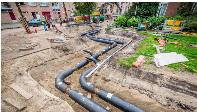
Figuur 1 Warmtenet in aanleg (Foto: Vattenfall, Jorrit Lousberg)
