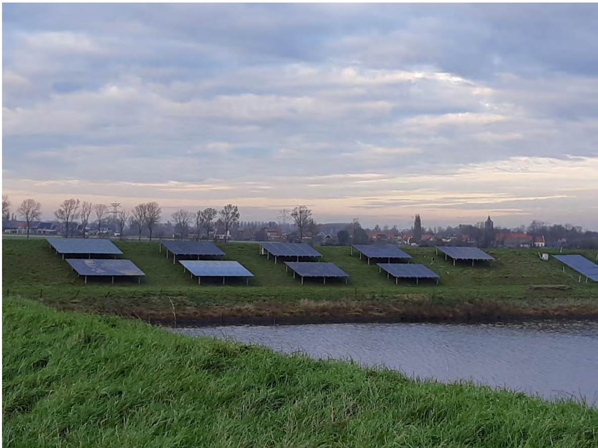
Foto 1. Opstelling van de tafels met zonnepanelen van Eurorail/TNO. Uiterst rechts het systeem van Delmeco met zonnepanelen in betonplaten.
