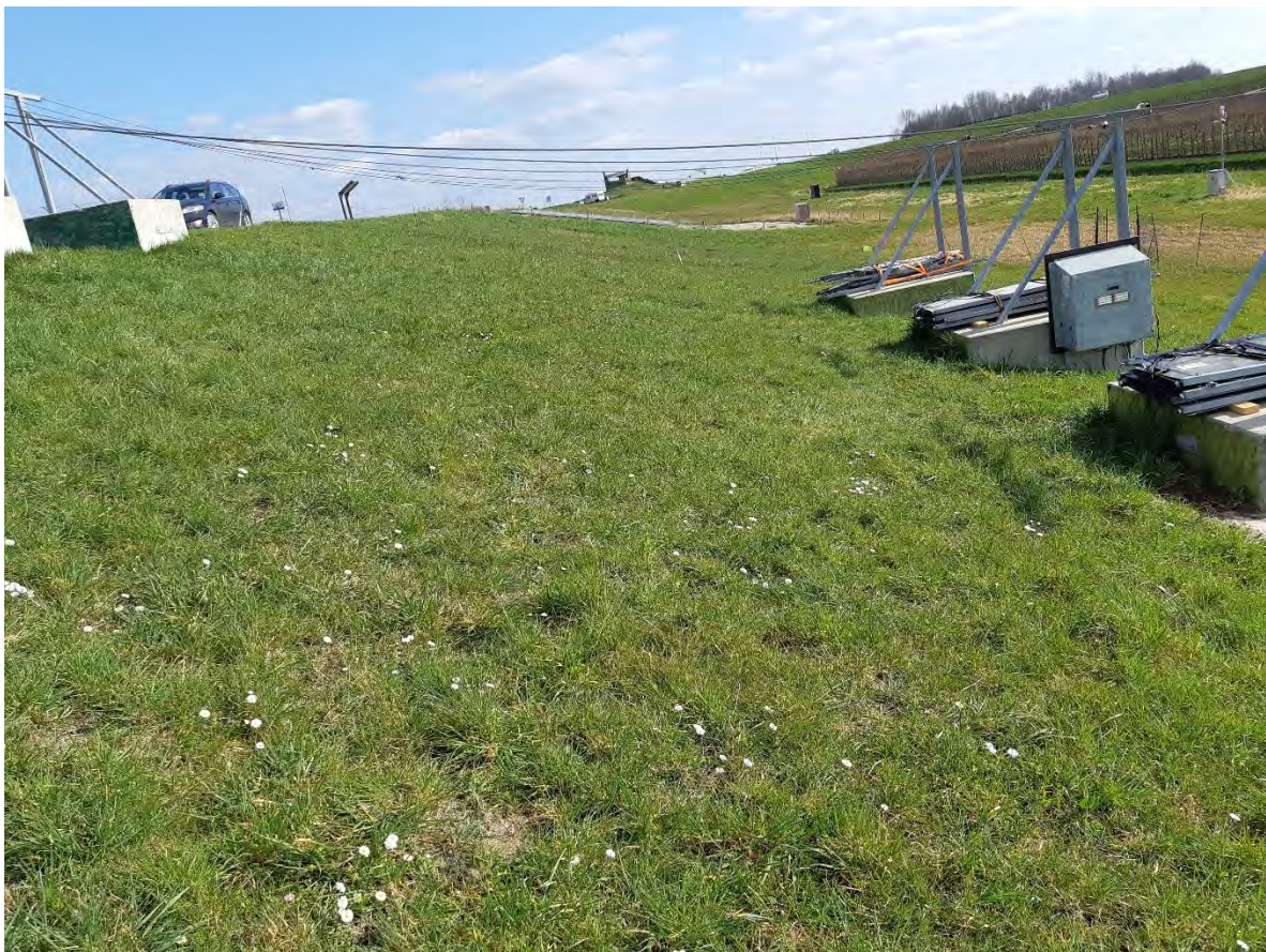
Foto 12. Het talud op 18 maart 2022. Goede grondbedekking met voornamelijk gras en o.a. madelief.
