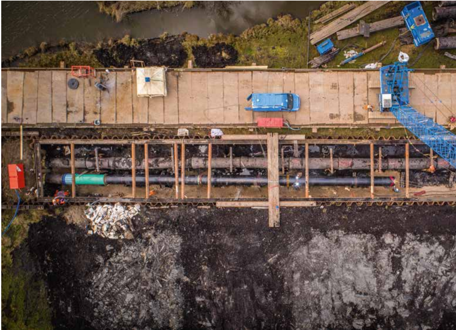
Aanleg transportleiding Waternet
