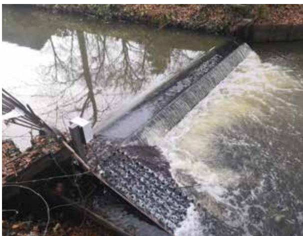
Afbeelding 3. Stuw Bonenburg is een relatief kleine hindernis voor trekvis, die soms zelfs onder water staat. Links op de stuw bij de prikkentegels het detectiestation. Met twee detectie-antennes werd onderscheid gemaakt tussen de route over prikkentegels en over de stuw.
