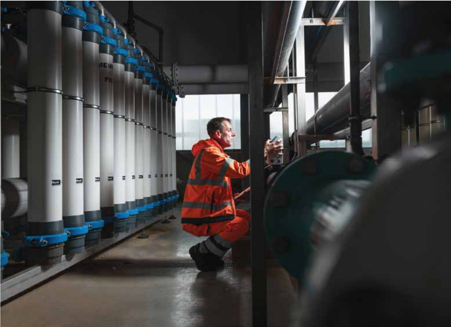
UF-membraansysteem, drinkwaterproductiecentrum De Gavers
