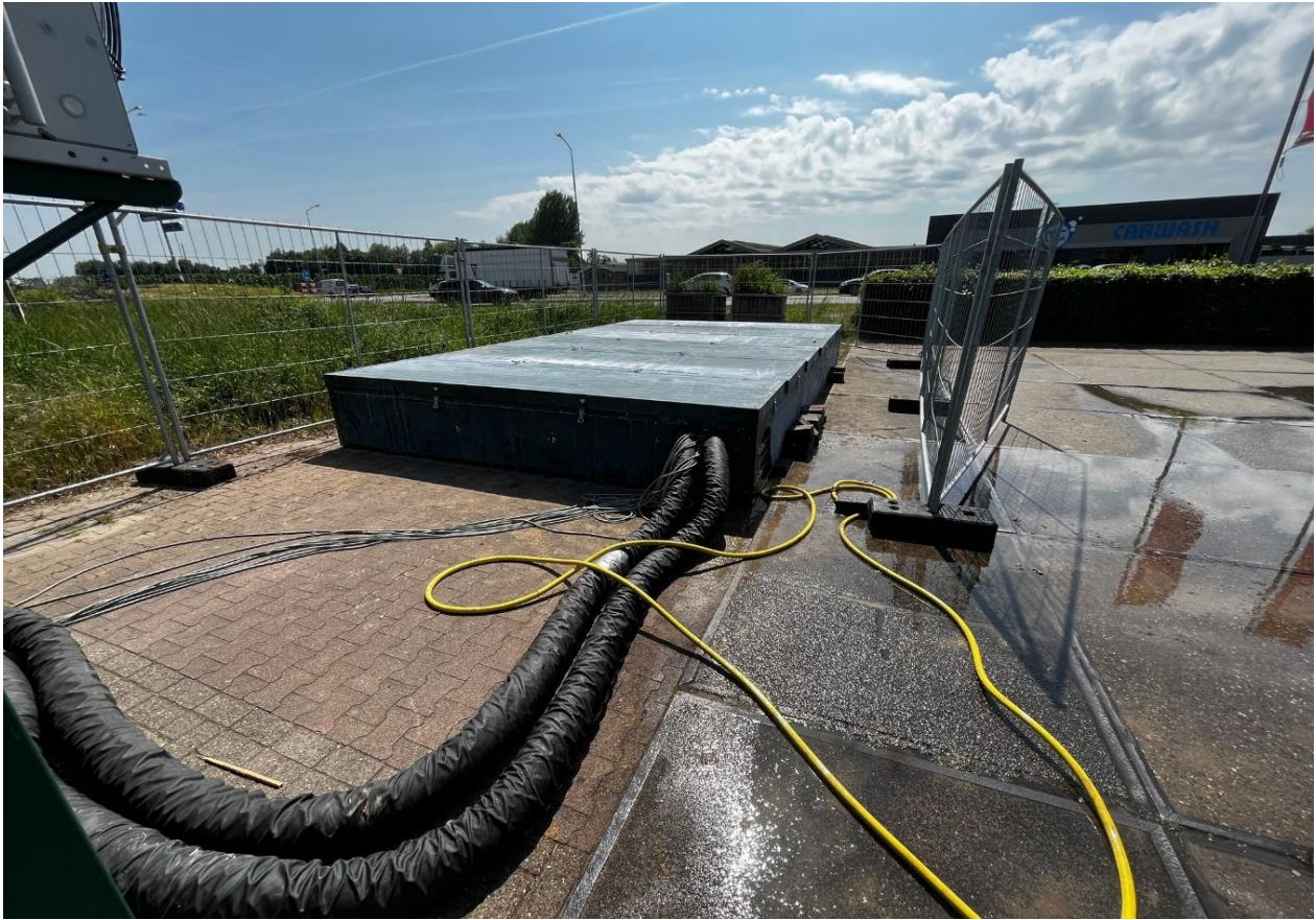
Figuur B1.6 Overzicht van het te behandelen vak. De vrieslansen bevinden zich in de afgesloten isolerende box (Foto TIBACH).
