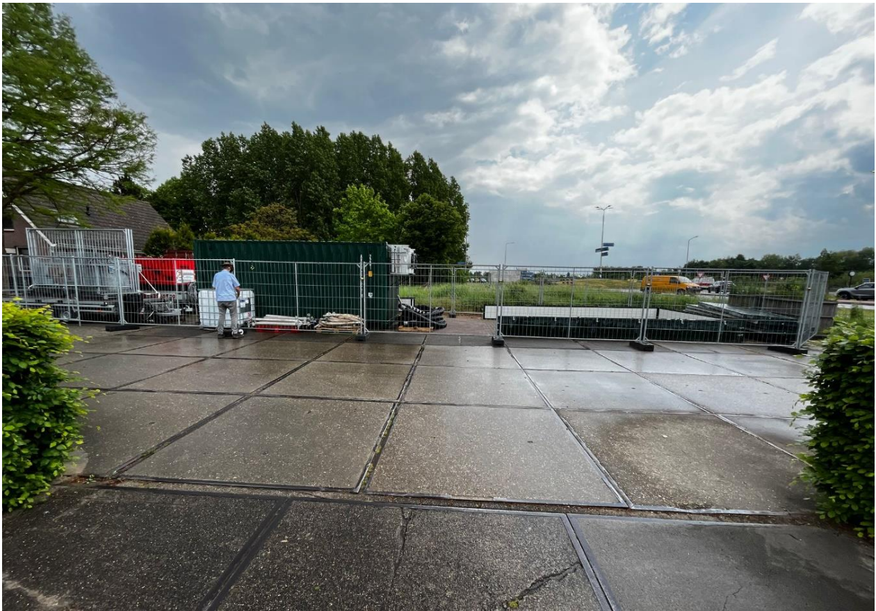
Figuur B1.7 Overzicht van de volledige proefopstelling met de isolerende box (rechts) en de koelinstallatie plus aggregaat (links) (Foto TIBACH).
