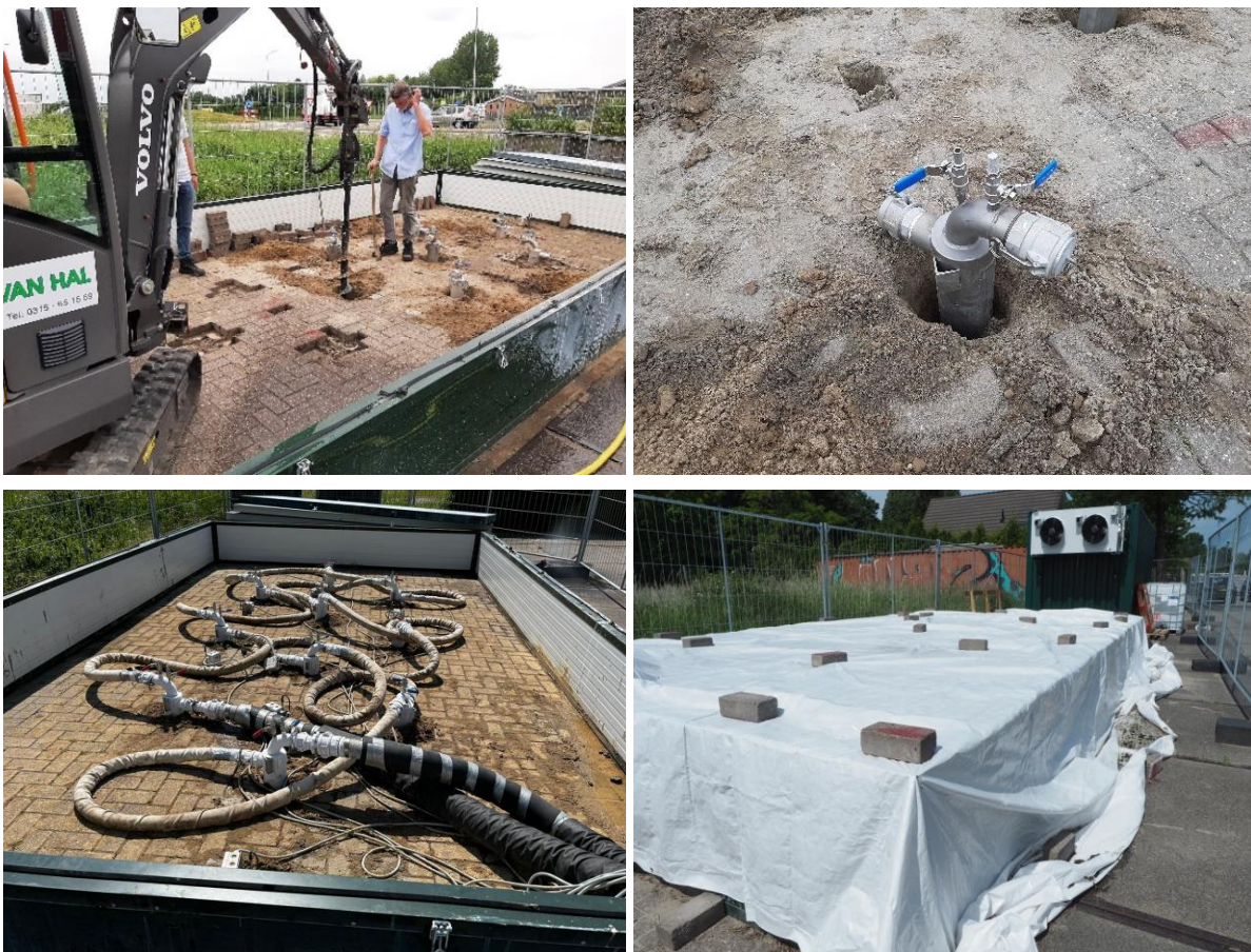
Figuur 6 Boren van de gaten voor de vrieslansen (linksboven), detail vrieslans na plaatsing (rechtsboven), de volledig aangesloten installatie net voor ingebruikname (linksonder) (Foto's TIBACH) en de operationele installatie afgedekt met een isolerende box en folie (rechtsonder) (Foto Jinze Noordijk).
