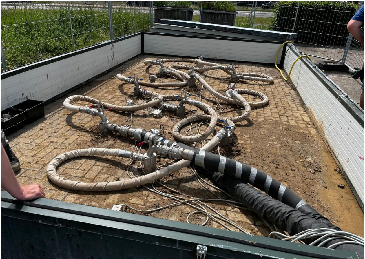
Figuur B1.4 Vrieslansen middels geïsoleerde slangen aangesloten op de koelinstallatie (Foto TIBACH).
