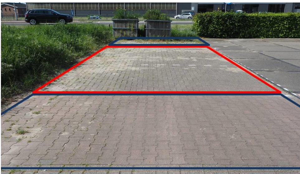
Figuur 5 Zijaanzicht van de testlocatie aan de rand van de parkeerplaats. Rood is het vak voor bevrozing (7x4 m). Blauw zijn vakken voor monitoring (Foto Jinze Noordijk).
