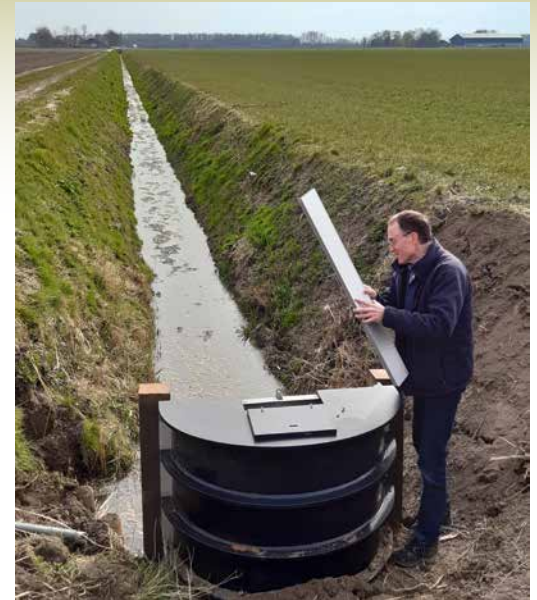
Nieuw geplaatste overstortput in referentiesloot.
