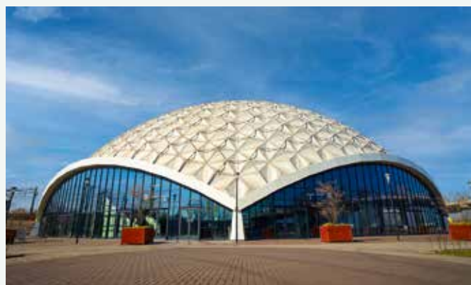
Amsteldrome, het voormalige Aviodome in Amsterdam Westpoort.
