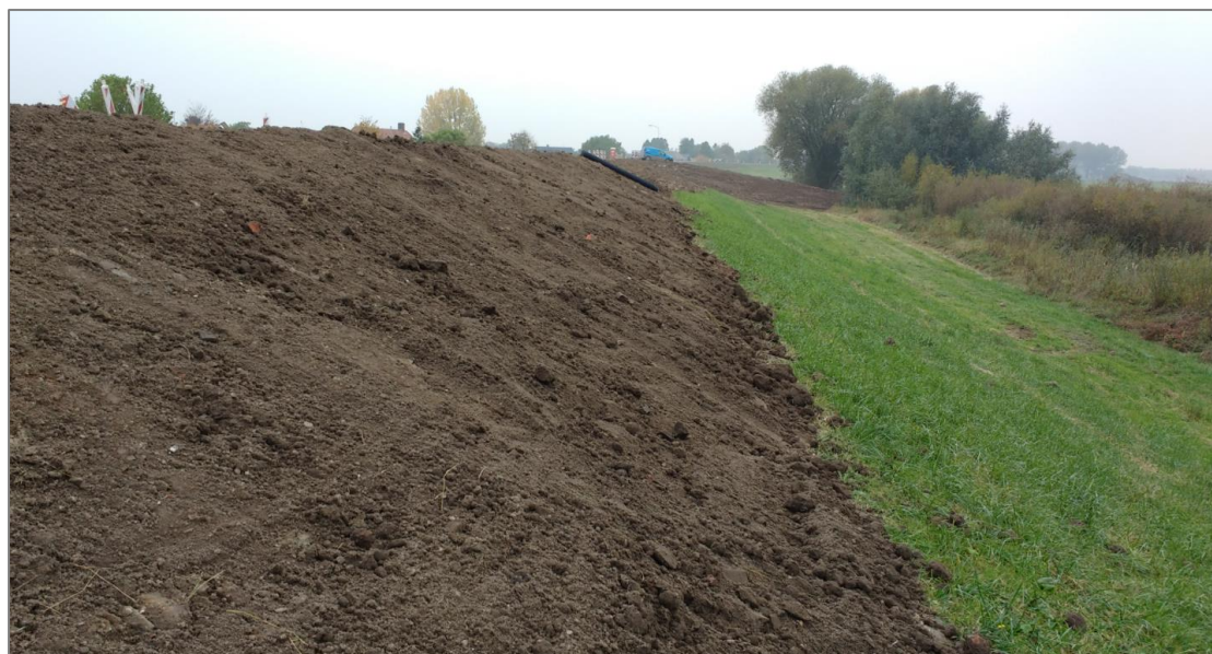
Figuur 8: Aanleg toplaag. | Foto: Waterschap Rivierenland.
