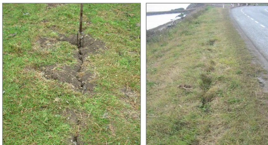
Figuur 3: Schade bij inspectie met gemaaide vegetatie (links) en ongemaaide vegetatie (rechts). De zichtbaarheid van scheuren verdwijnt al bij een matige hoogte. | Foto's: Waterschap Rivierenland.
