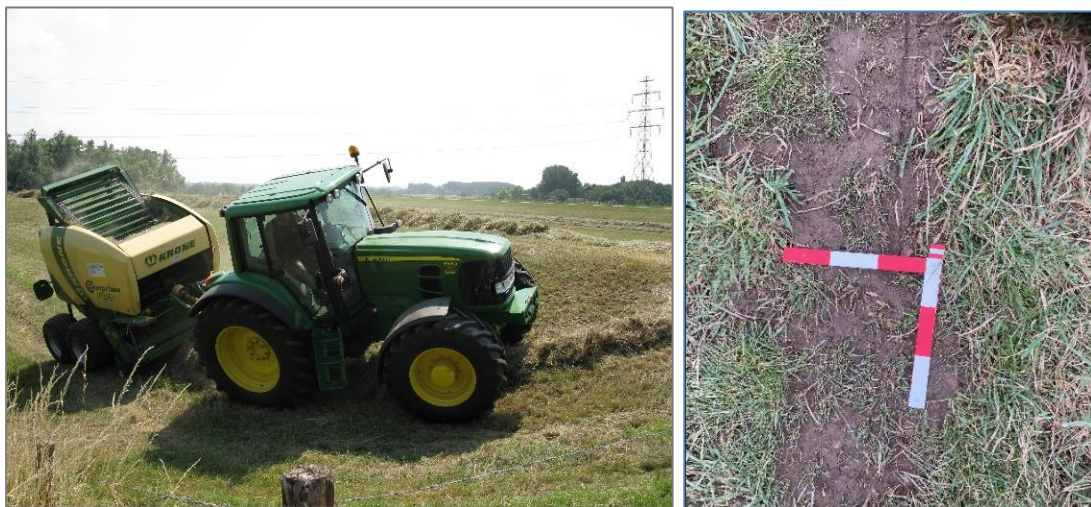
Figuur 7: Onderhoudswerkzaamheden grasbekleding met behulp van tractor en balenpers (links) en schade aan de grasbekleding als gevolg van spoorvorming (rechts). | Foto's: Waterschap Rivierenland.
