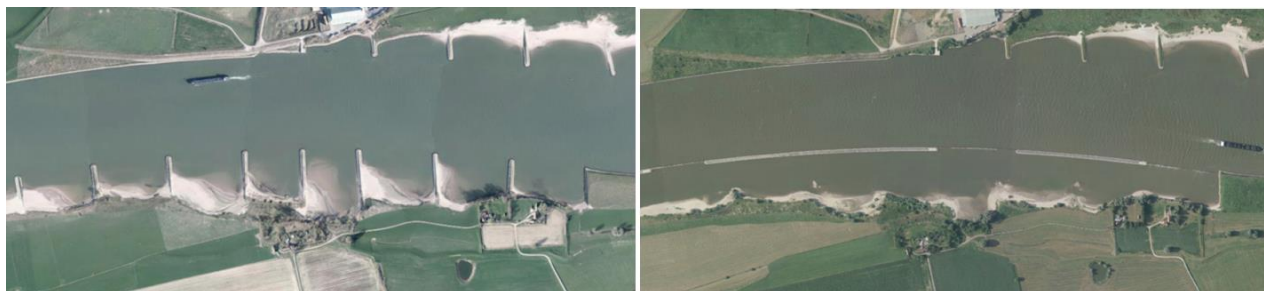
Afbeelding 1. Gedeelte van het traject bij Wamel, vóór (foto links) en ná (foto rechts) aanleg van de langsdammen in 2015
