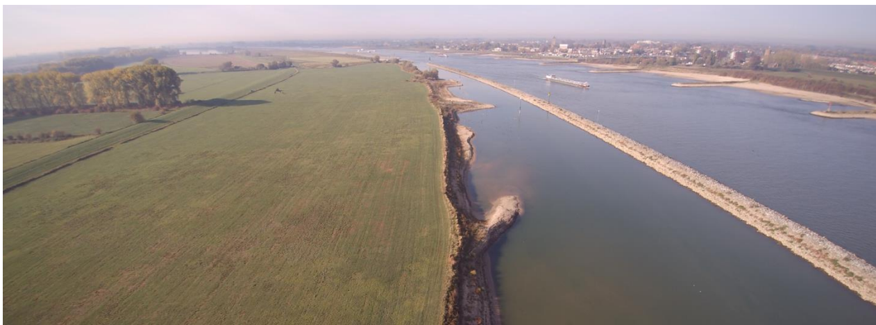
Afbeelding 2. Eroderende steile oever in het traject-Wamel; de schuin uitstekende vorm is een 18 e -eeuwse krib die sinds de aanleg bloot gespoeld is. Het laat goed zien hoe sterk de erosie is geweest sinds de aanleg van de langsdam
