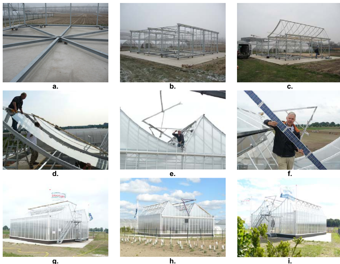
Figuur 6.1 a. Betonnen fundering met de draaiconstructie b. Opbouw constructie c. Eerste kap geplaatst d. Plaatsing van gebogen (gehard) glas. e. Plaatsing van het zonnevolgsysteem f. Zonnecel modules g. h. i. Verschillende aanzichten van de complete kas
