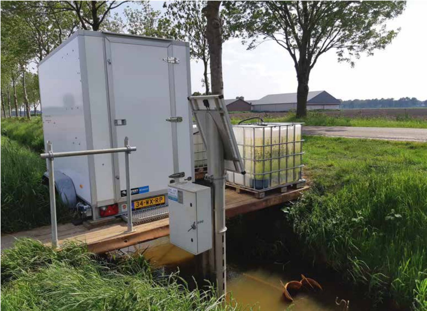
Uitstroompunt Vinkenloop: trailer met meetapparatuur (temp, EGV, tot-P, NH4, NO3)
