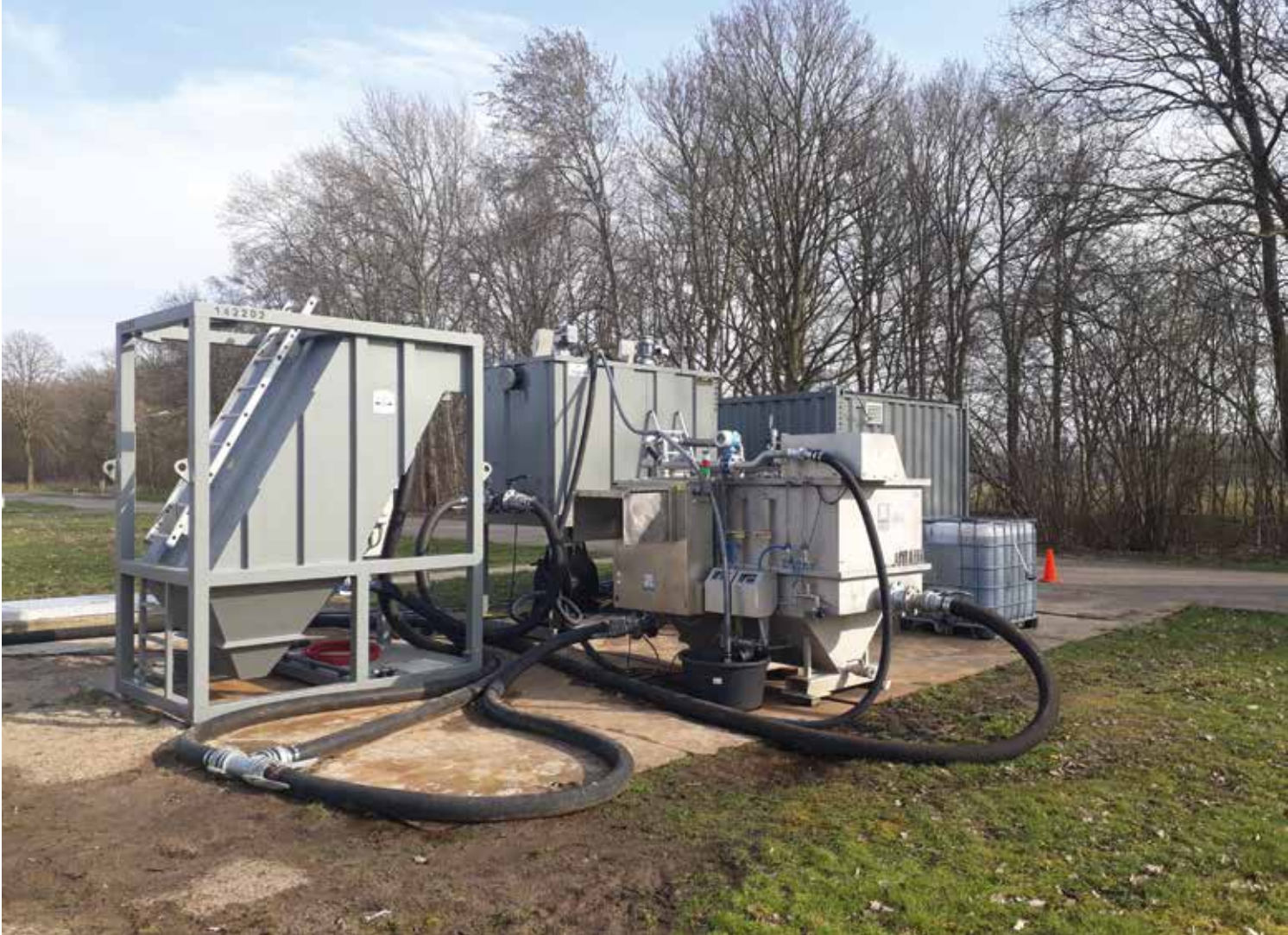
Figuur 1: Opstelling van de pilotinstallatie PAK + Doekfiltratie op rwzi Vinkel
