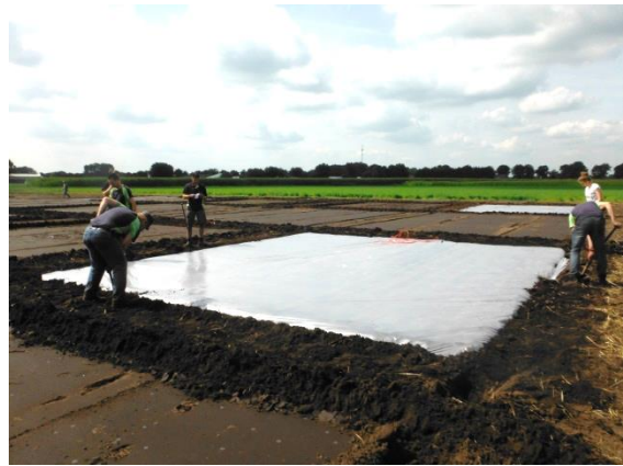
Foto 11. Afdekken van de grond met VIF-folie.
