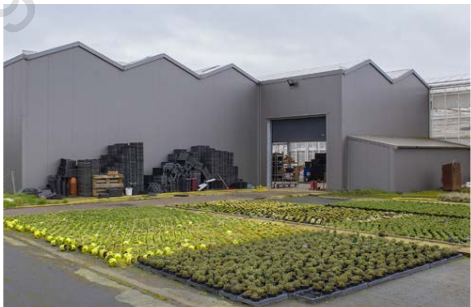
De zonnepanelen liggen op het dak van de loods.
