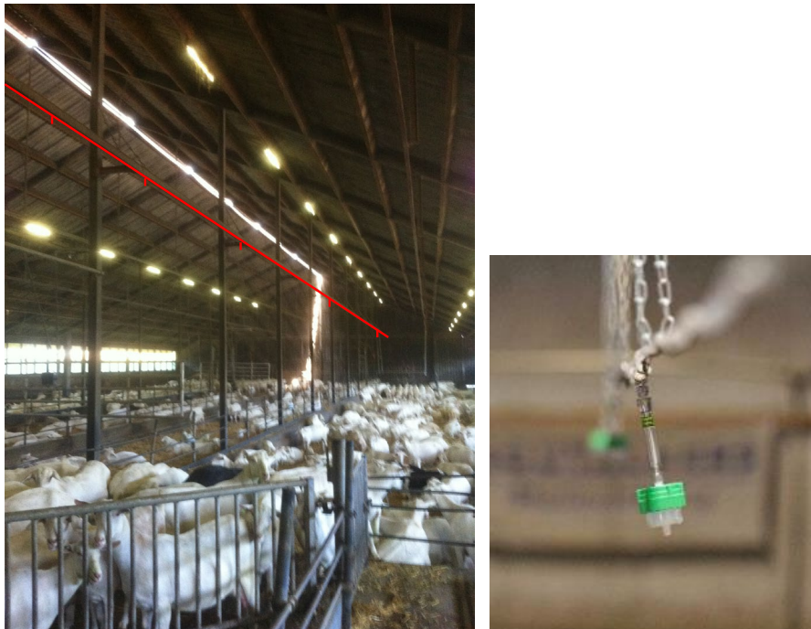
Figuur 2.1 Meetopstelling met monsternameleiding. Links: voorbeeld monsternameleiding met monsternamepunten in de stal. Rechts: voorbeeld van monsternamepunt met kritische opening en stoffilter.
