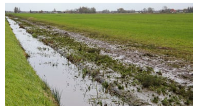
November 2021, Twee terrassen vormen het aangepaste talud.
