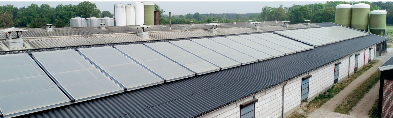
Zonnecellen zorgen voor warm water van circa 80°C, voldoende warm voor de aanmaak van de melk voor de kalveren
