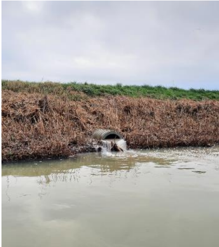
Figuur B2.6 Flinke afvoer vanuit de kavelsloten via duikers naar de Vuursteentocht; de grijzige kleur van het water in de tocht komt door fijn sediment vanuit de kavelsloten.
