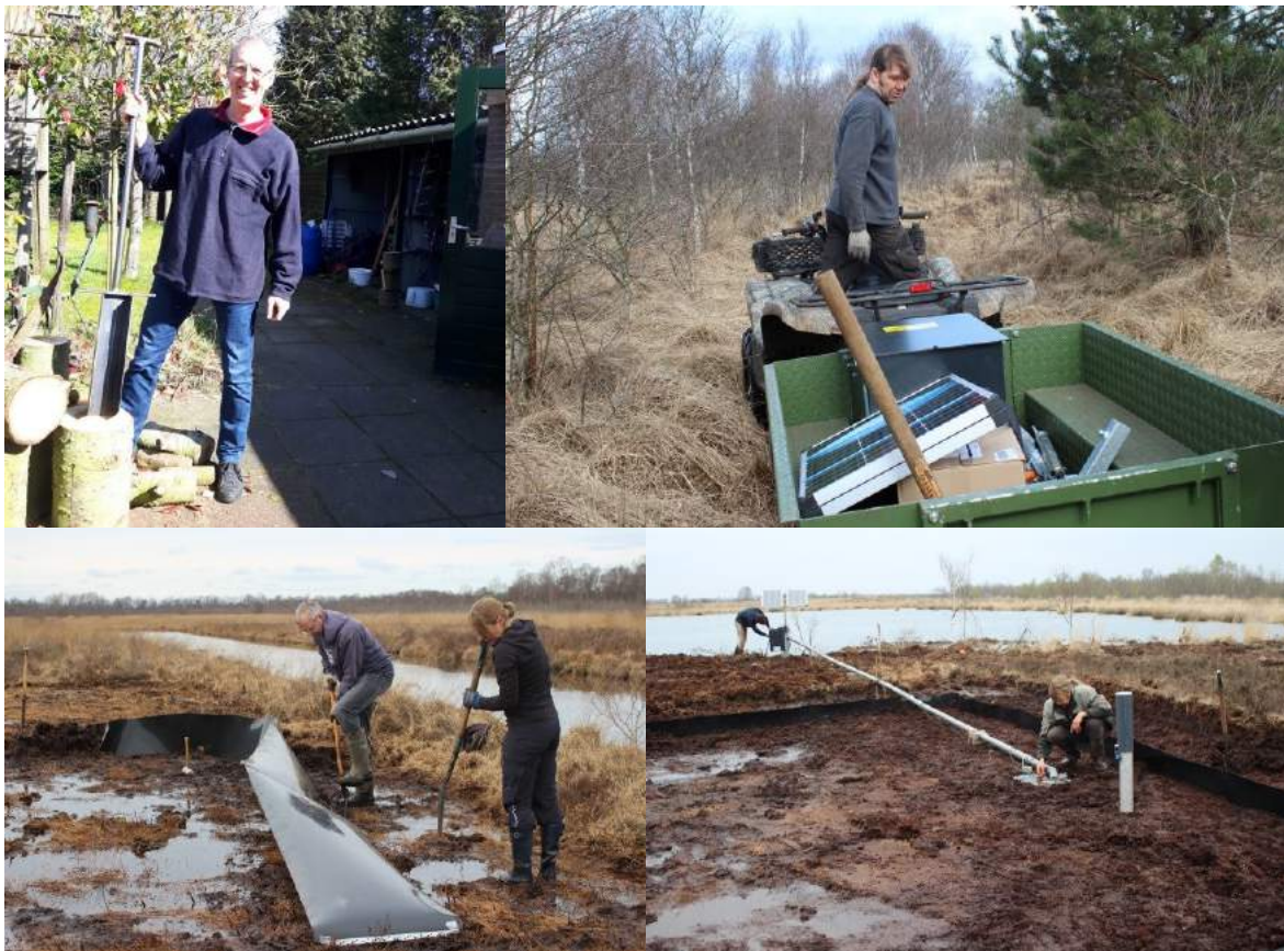
Figuur 16. Foto's van de hydrologische inrichting van de plas-dras experimenten. Het ingraven van het scherm bleek zwaar werk, ten behoeve daarvan is door Verbelco een speciale veenschap ontworpen (foto's links). In de foto rechtsonder is de gerealiseerde opstelling van pomp, vulbassin en peilbuis in het Bargerveen te zien. Foto's: Jos von Asmuth.
