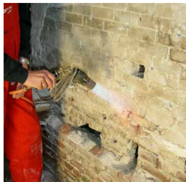
Verwijdering van zwamwefsel door afbranden. Foto: Van Lierop B.V., Alphen aan den Rijn
