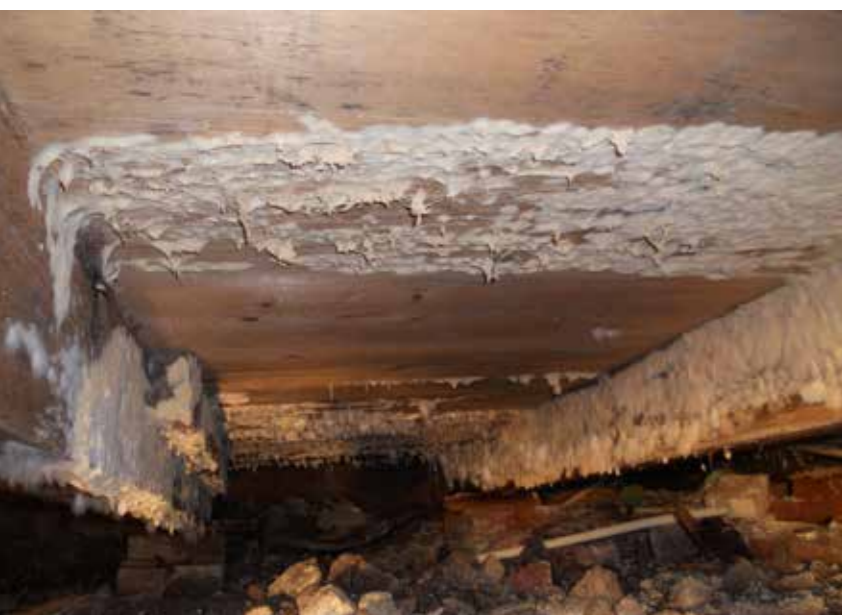
Onderzoek kruipruimte: hier is mycelium van huiszwam aanwezig. Foto: Van Lierop B.V., Alphen aan den Rijn
