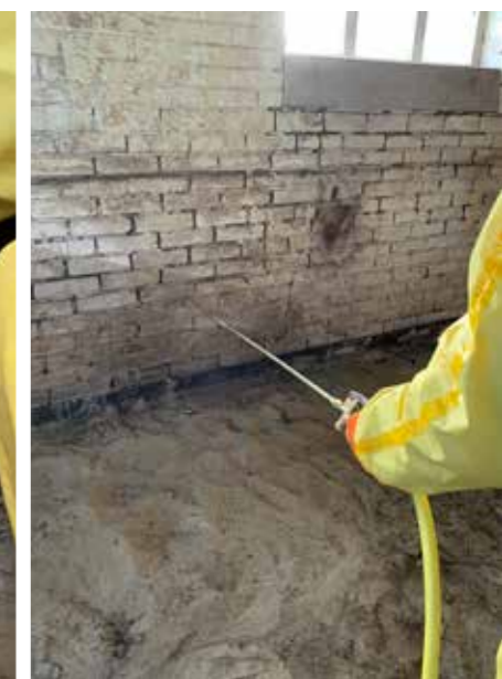
Oppervlaktebehandeling van de muur. Foto: Hoekstra Bedrijfs hygiëne, Tijnje
