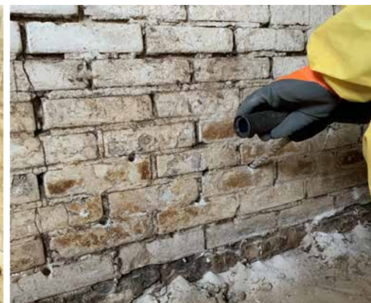
Bij sterke zwamwoekering op muren worden in een verspringend patroon gaten geboord en dan gevuld met bestrijdingsmiddel. Foto: Hoekstra Bedrijfs hygiëne, Tijnje
