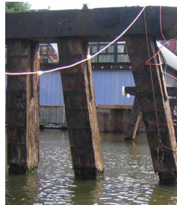
Zachtrot zorgt voor erosie van houten palen op de waterlijn. Foto: SHR
