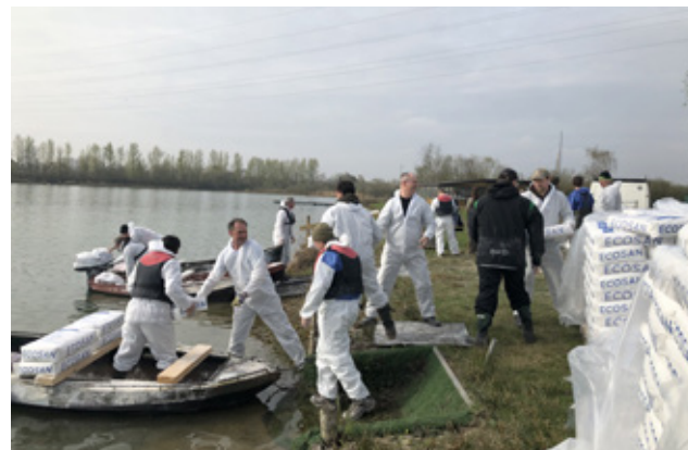
Door bekalking van het water is de baggerlaag geslonken en is de ecologische waarde van het water sterk toegenomen.
