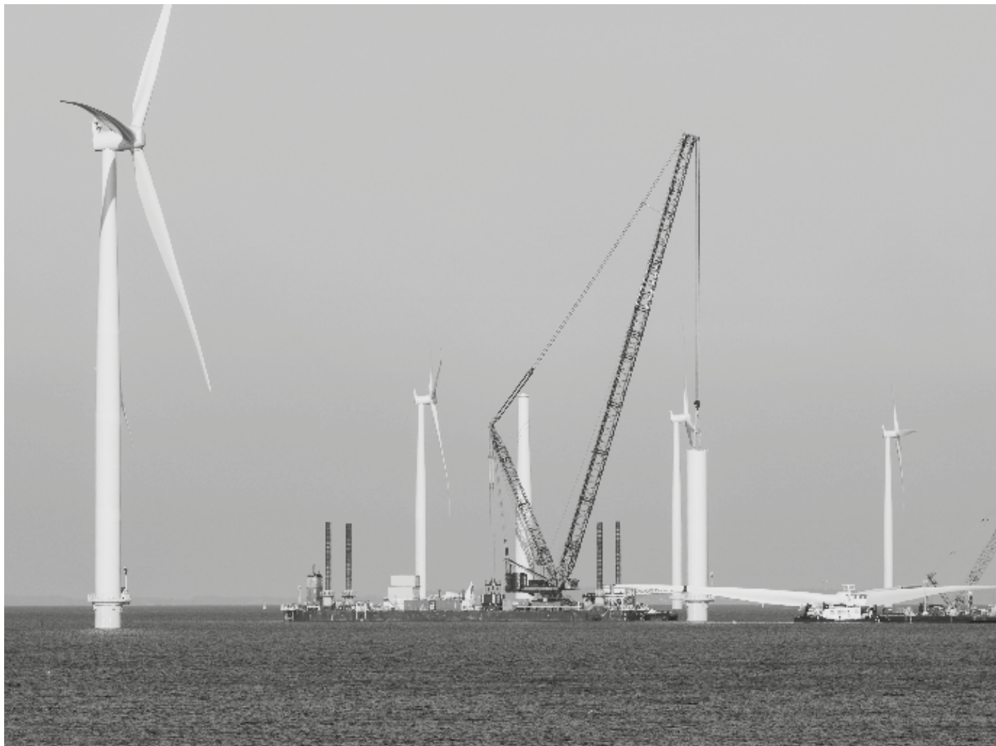
Bouwplaats nieuw offshore windpark nabij de Nederlandse kust • Foto Shutterstock
