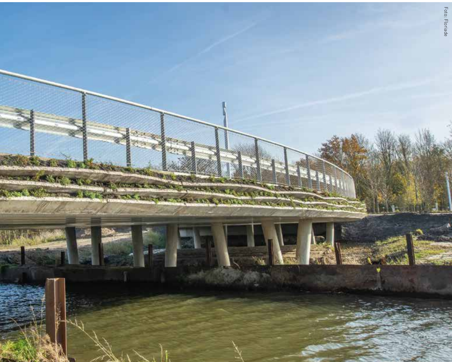
De Beverbrug is de eerste verkeersbrug in Nederland van cementloos beton (geopolymeerbeton).
