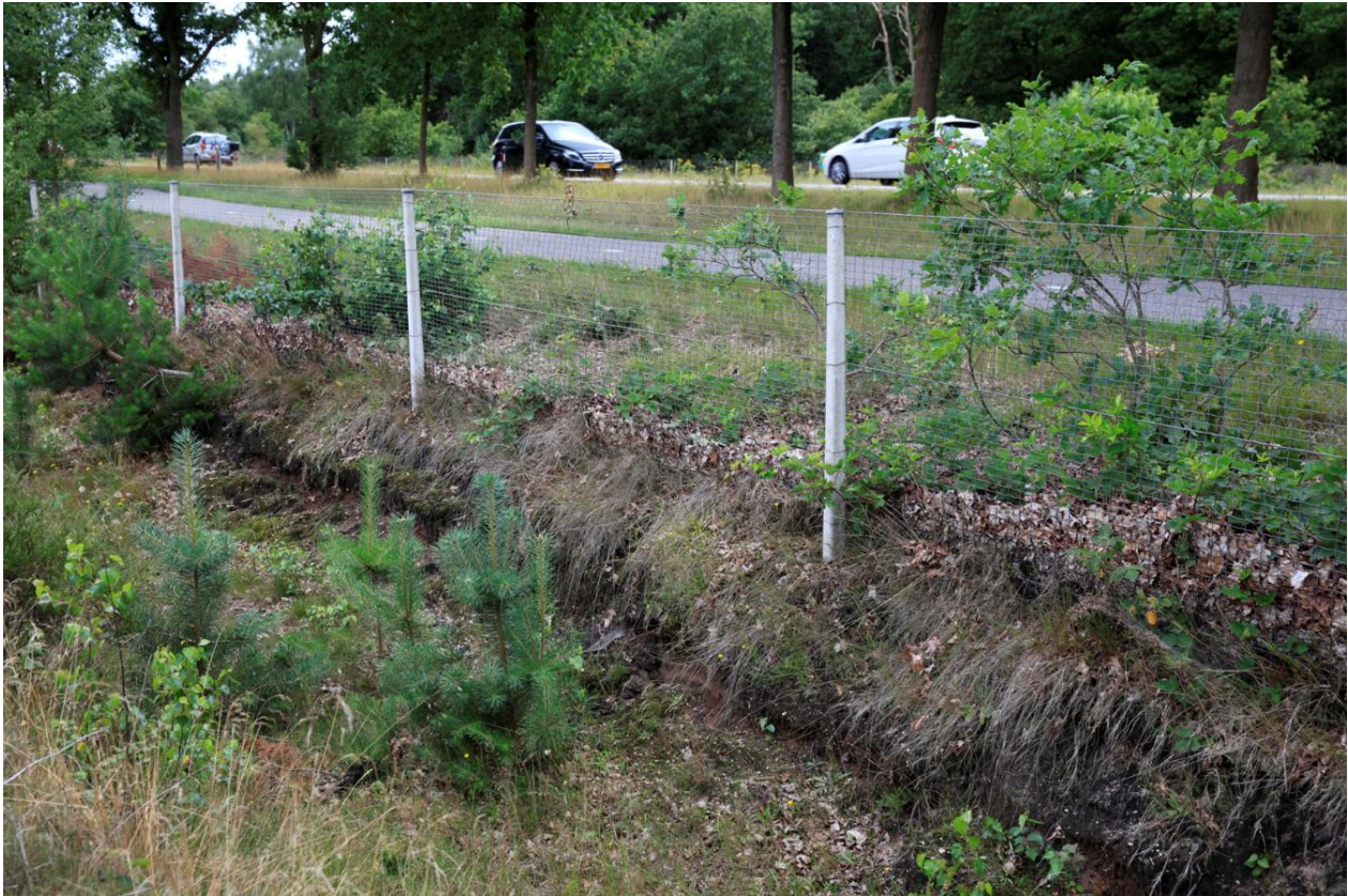
Figuur 17 Op plekken waar de N227, een provinciale verkeersweg op de Utrechtse Heuvelrug, heideterreinen doorsnijdt, zijn 1 m hoge rasters geplaatst in combinatie met een circa 1 m hoge steilwand om te voorkomen dat reeën de weg betreden. Dit ontwerp is gekozen op basis van esthetische overwegingen. Aantasting van het open heidegebied wilde men zo veel mogelijk beperken, maar tegelijkertijd wilde men wel een functionele barrière realiseren om aanrijdingen met reeën te voorkomen.
