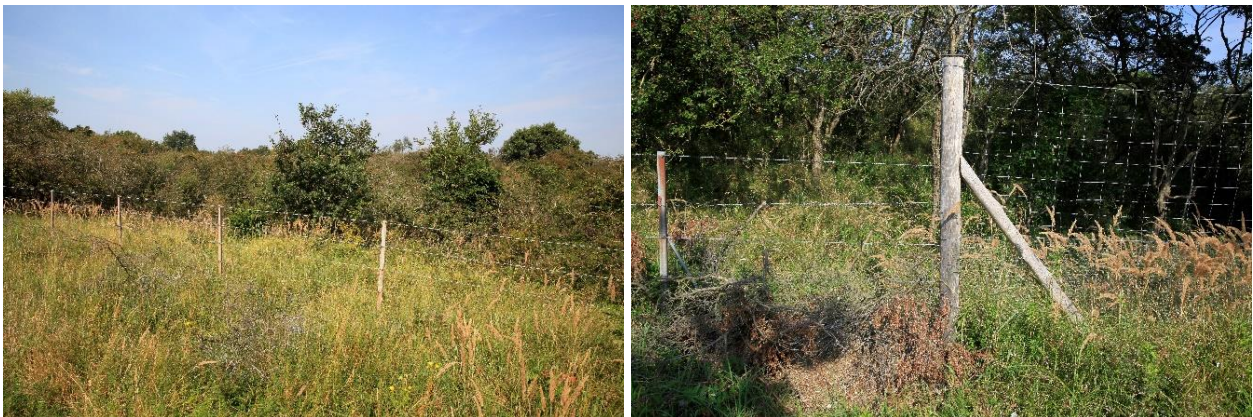
Figuur 6 Standaardraster (links) – 1,2 m hoog en bestaande uit een 5-draadraster – en de aansluiting van dit standaardraster op het hoge faunaraster (rechts).
