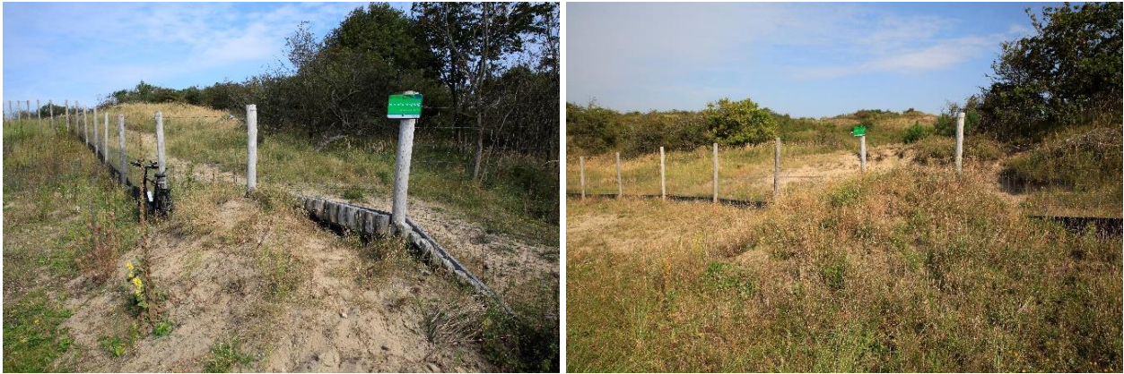
Figuur 5 Insprong ten oosten (links) en westen (rechts) van de natuurbrug, die dieren in staat stelt om het faunaraster te passeren vanaf de wegzijde als ze toch onverhoopt op de weg terecht zijn gekomen.
