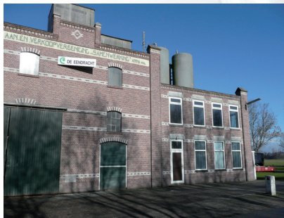
Coöperatie De Eendracht in Rouveen vlakbij de A28. Over een paar jaar moet het kantoor (rechts) helemaal zijn verbouwd.
