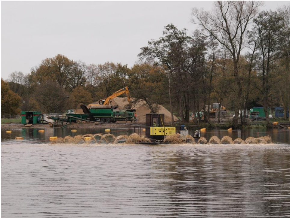
Afbeelding 2. Aanbrengen zandlaag (2015)
