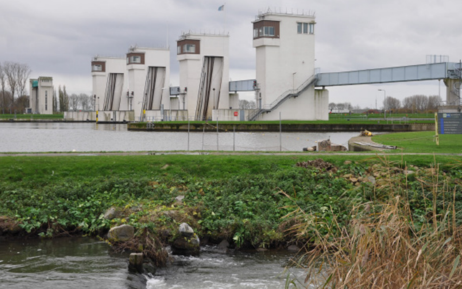
Stuw- en sluizencomplex bij Lith. Beeld: Van Roosmalen van Gessel Architecten
