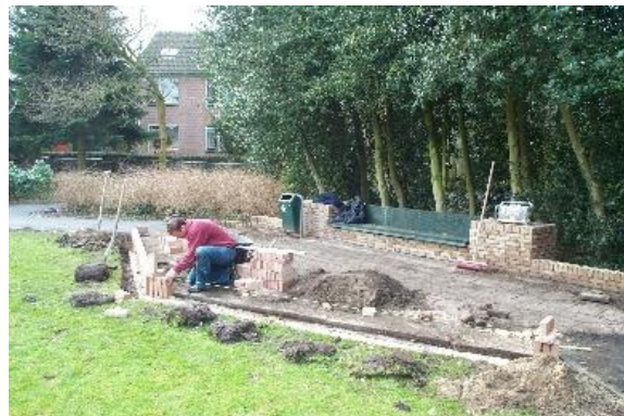
Afb. 93 en 94 Links: het plateau werd vernieuwd en de houten pergola vervangen door een stalen. Rechts: herstel van een van de zitjes, met een stalen bank. (Foto's G. Niesten)
