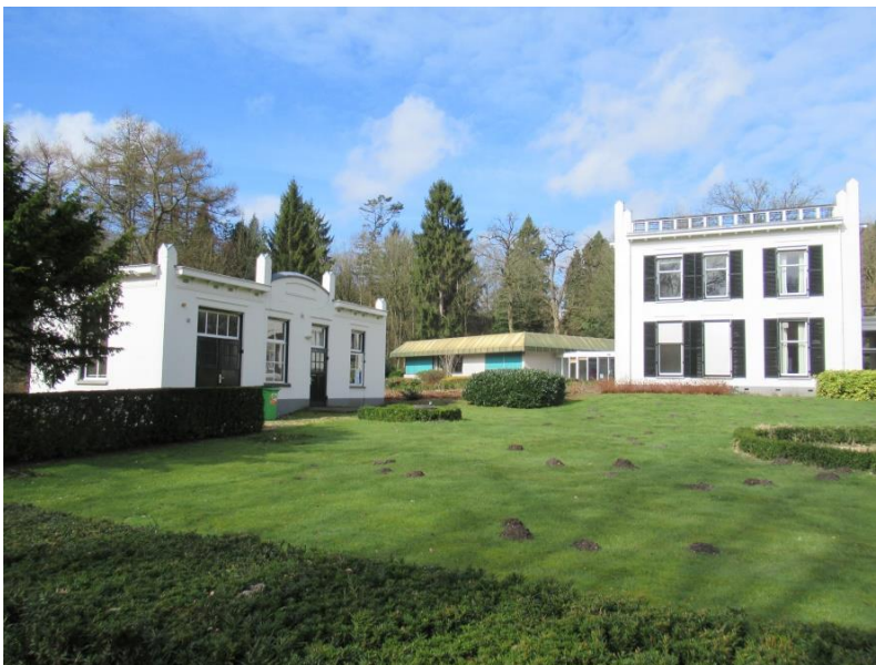
Huidig (door)zicht op de bebouwing
