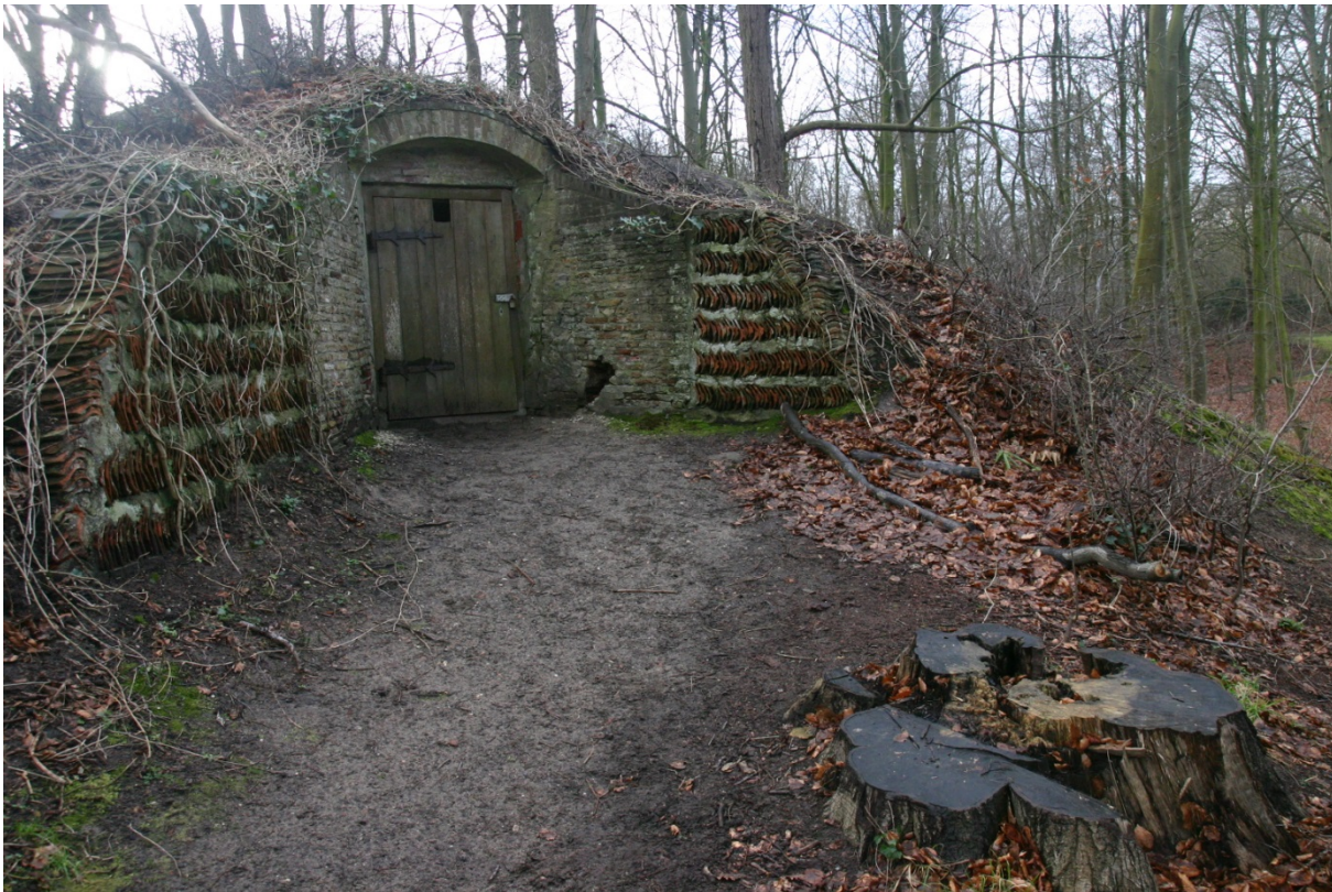
Afb. 22 Toegangsdeur van de ijskelder (05-02-2013).
