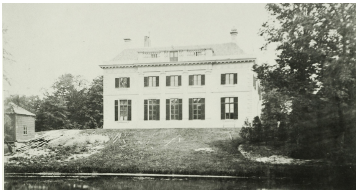
afb. 12 Westelijk aangezicht op huis Elswout circa 1882, met links het knechtshuisje of voormalige kapkamer, die op de foto vol zichtbaar is omdat het omringende bosje reeds was gerooid. De ligging van de bosjes is precies zoals aangegeven op de kaart van 1812.
