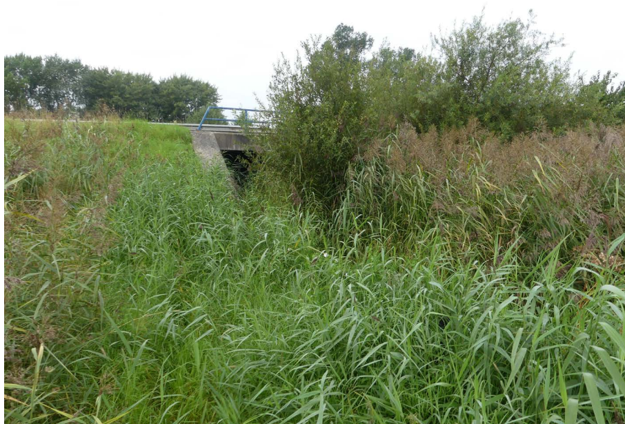
Figuur 5 Faunapassage Cronesteyn, westelijke tunnel, westelijke ingang. De ingang is grotendeels aan het zicht onttrokken door hoge wilgen- en rietvegetatie.
