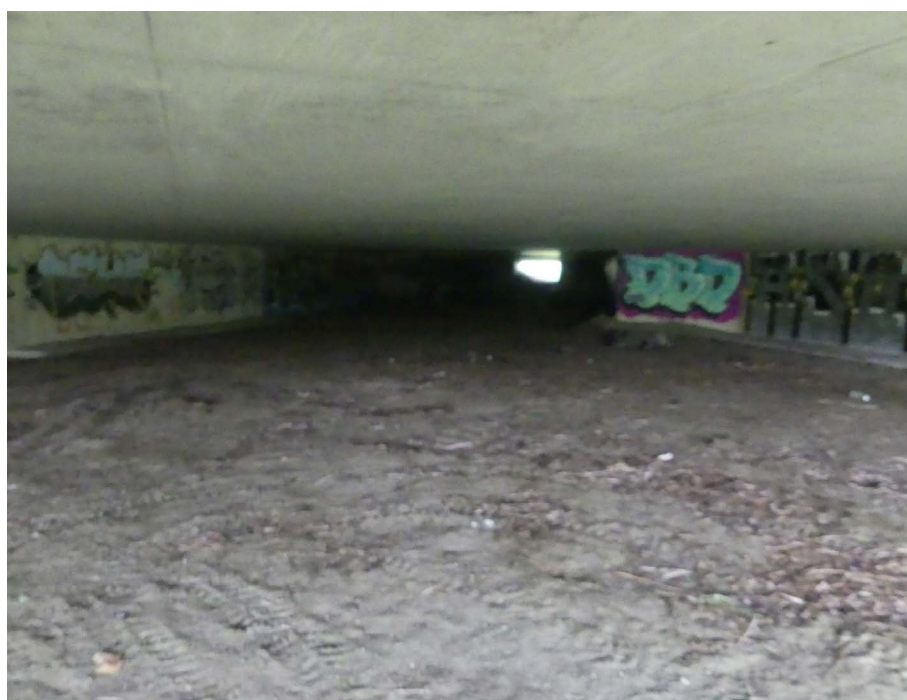
Figuur 10 Faunapassage Cronesteyn, oostelijke tunnel. Blik naar binnen vanaf de westkant. De bodem is kaal, zanderig en vrij droog. De tunnel versmalt van west naar oost.
