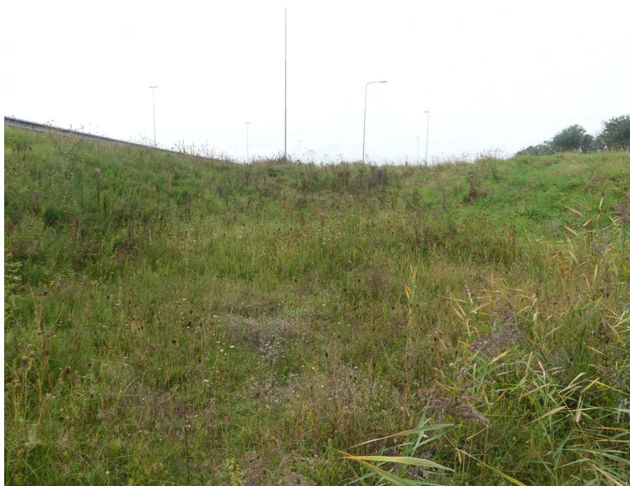
Figuur 2 Faunapassage Crone- steyn, open deel tussen de twee tunnels in. Op de taluds van de omringende wegen is een vrij schrle vegetatie aanwezig.
