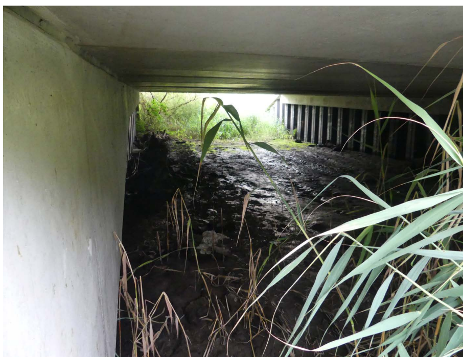
Figuur 6 Faunapassage Cronesteyn, westelijke tunnel. Blik naar binnen.
