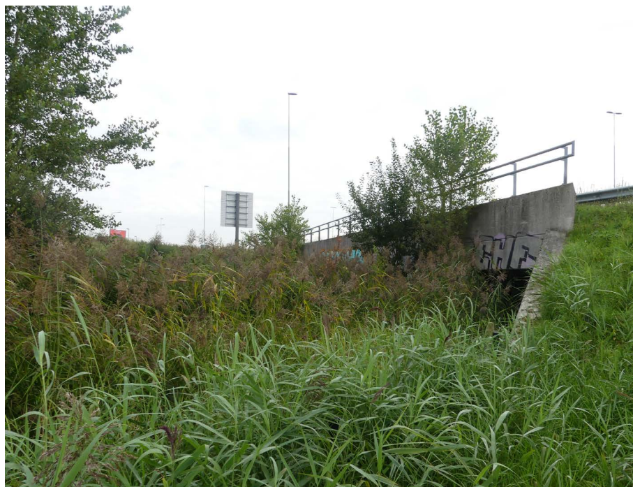
Figuur 9 Faunapassage Cronesteyn, oostelijke tunnel, westelijke ingang. De ingang is grotendeels aan het zicht onttrokken door hoge wilgen- en rietvegetatie.
