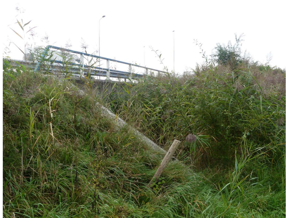
Figuur 8 Faunapassage Crone- steyn, westelijke tunnel, ooste- lijke ingang. Ook aan deze kant is de ingang dichtgegroeid.
