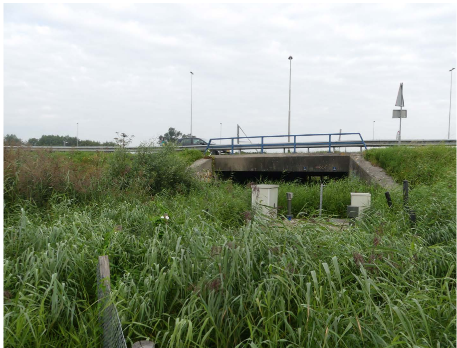
Figuur 12 Faunapassage Crone- steyn, oostelijke tunnel, ooste- lijke ingang. De vegetatie is hier iets minder hoog dan aan de andere kant.
