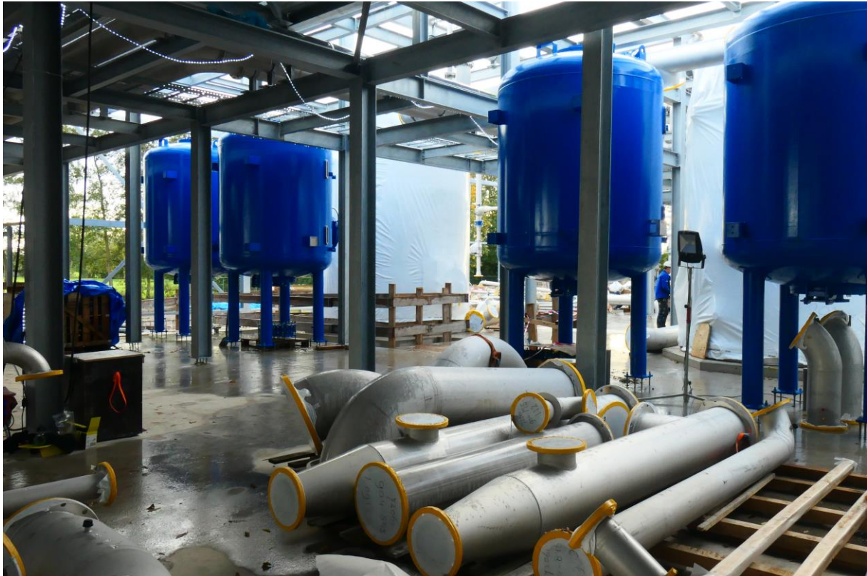
Afbeelding 1. Zuiveringsstation De Put (Nieuw-Lekkerland) in aanbouw
