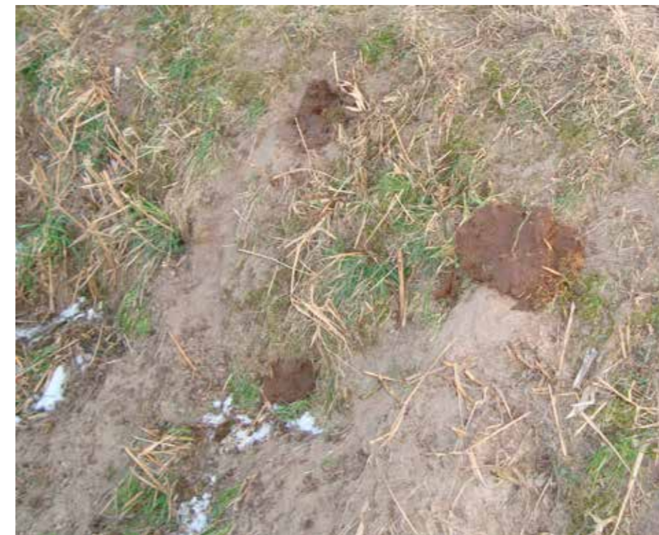
Dichtgemaakte nestingen om het resultaat te controleren. Foto: KAD
