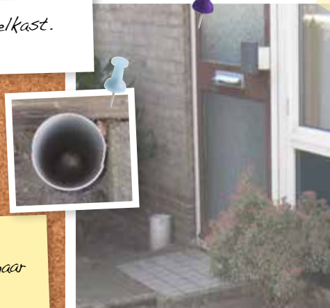
Welkom! Een open verbinding naar de kruipruimte naast de voordeur. Foto: Cyriel Doevendans
