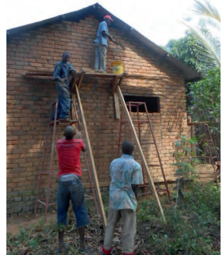
Afdichten van overige muuropeningen.
