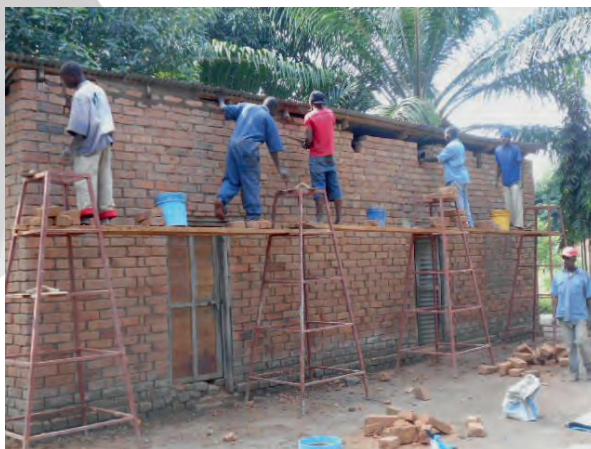
Inbouwen van de Eave Tubes onder de dakrand.
