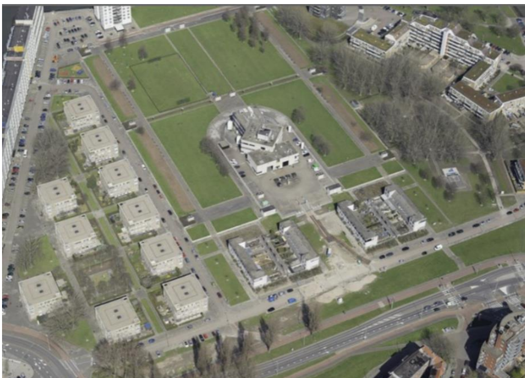
Afbeelding 3. Ondergrondse rwzi Dokhaven
