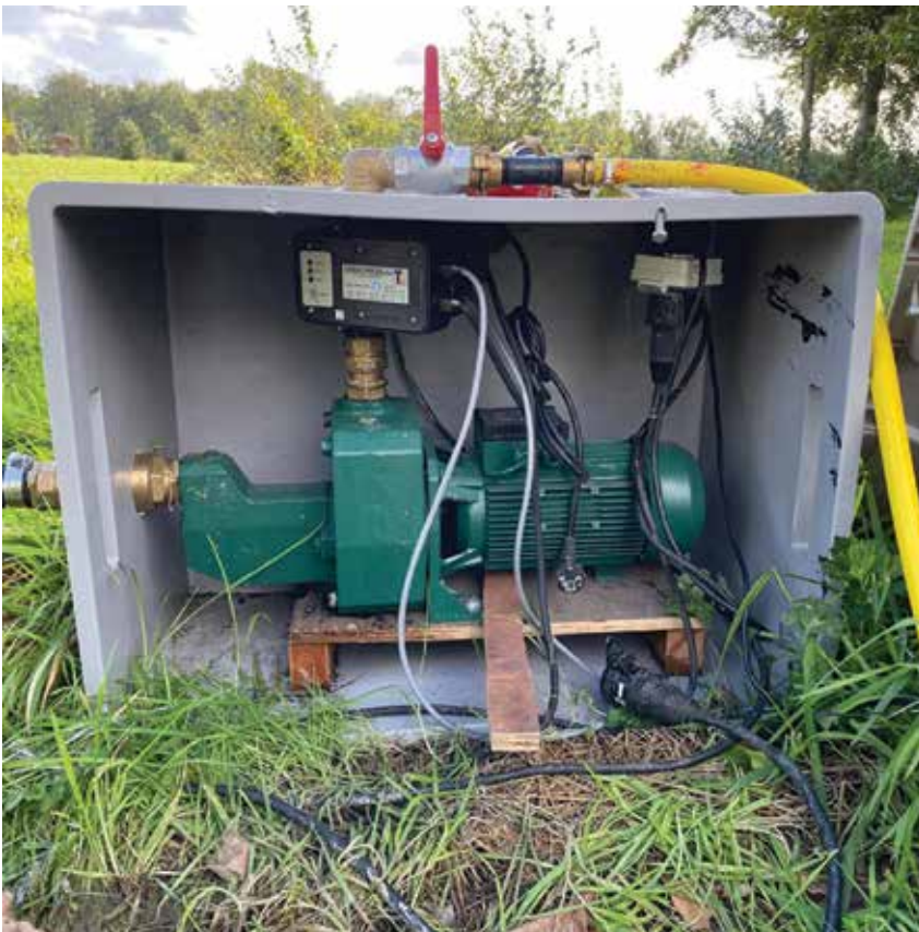
Pomp om het bemalingswater over te pompen naar een stilstaand reservoir.
