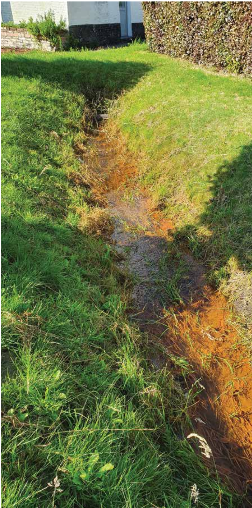
Oxidatie van het ijzer in de gracht.
