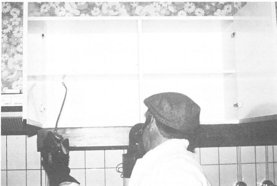
▲ Kieren en naden in aanrechtkastjes behandelen. (Foto's D. P. Kempe.)
