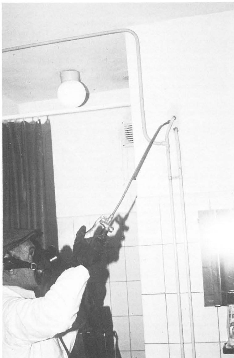
▲ Ook spuiten bij doorvoeropeningen van de centrale verwarming, de waterleiding, etc. (Foto D. P. Kempe.)
