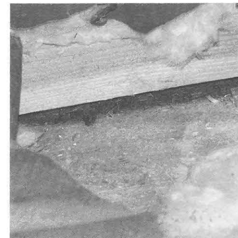
drukvilt onder de balklaag, voedselbron voor kleermotlarven (foto Retham - Zwolle)
