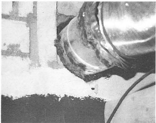
drukvilt rondom buizen in mantelgaten voor geluidsisolatie (foto P.C. Groebe)
