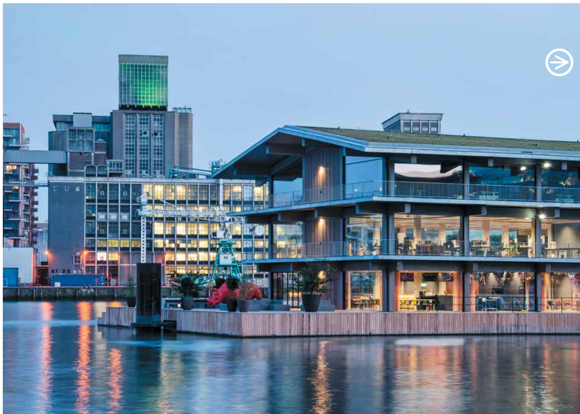
➔ Het Floating Office Rotterdam wordt verwarmd met water uit de Rijnhaven. Het gebouw won dit jaar de Europese 'Out of the Box Heat Pump Award'.
