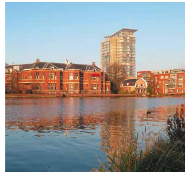
⇒ Thermische Energie uit Oppervlaktewater (TEO) project Mariastichting Haarlem
